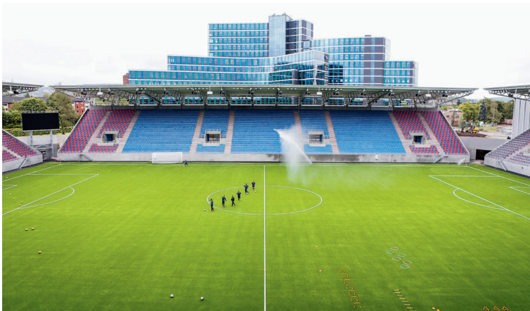
DYRERE ENN PLANLAGT: Vålerenga Stadion sprakk med 50 millioner på toppen av budsjettet på 700 millioner kroner. Da var innbyggingen av hjørnene allerede droppet.
